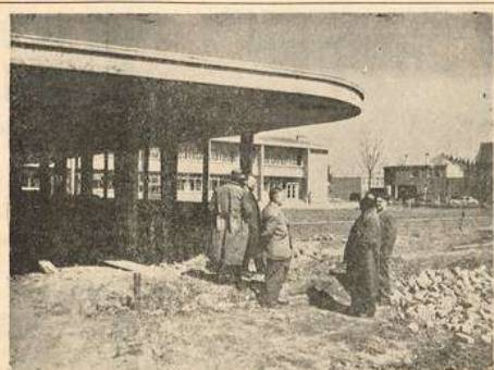
Le Député-Maire en inspection durant les travaux au groupe Sévigné. Il est accompagné des architectes et des entrepreneurs.
