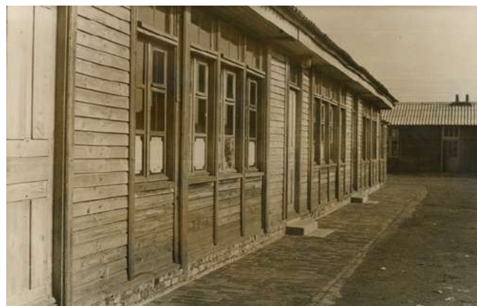
Construit au début du XX ème siècle, le groupe scolaire Voltaire-Sévigné fut presque entièrement détruit lors du bombardement d'avril 1944. Dans l'attente de la reconstruction, à la libération, en 1945, des baraques provisoires en bois ont accueilli les élèves pendant 10 ans.
